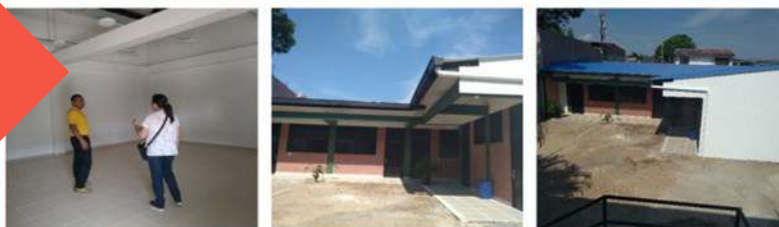
Construcción 2 aulas y batería sanitaria en la sede central de la IE Nuestra señora de Manare
