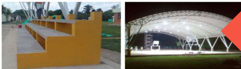
Construcción Cubierta IE San Juan de Los Llanos Vereda las Guamas
